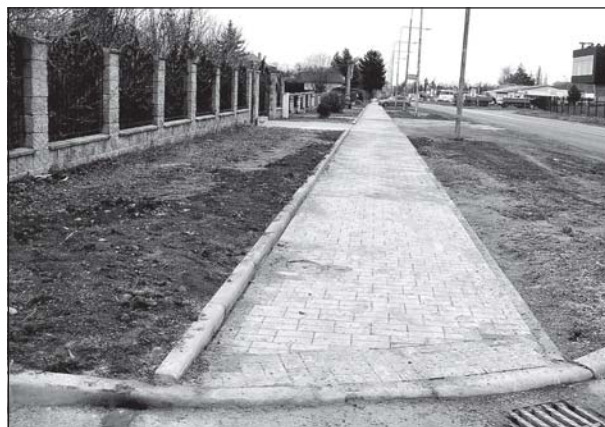
Nový chodník na ulici Pražská tvoří 940 velkých obrubníků a 42 000 ks dlažebních kostek.
