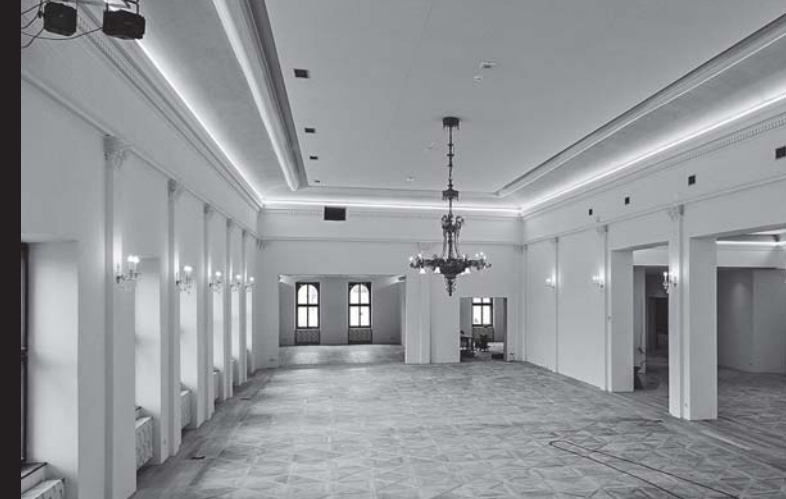
Opravený velký sál Besedy. Foto: Pavel Čírték
