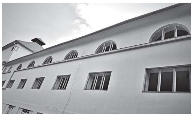
Oprava oken sokolovny
